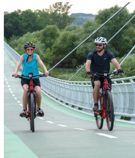
Radfahrer- und Fußgängerbrücke Schlosshof – Devínska Nová Ves
